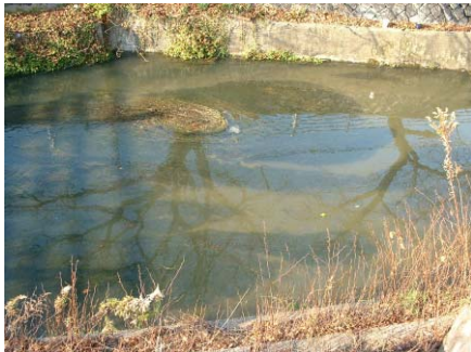
猿投橋の落差の上流側
